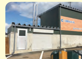
三国観光ホテル メーカー:KWB (オーストリア) 製品名:マルチファイア 出力:240kW (120kW×2台)
